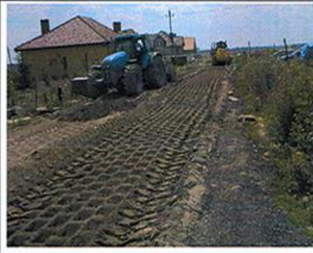
Rys. 4. Ubijanie rozścielanego spoiwa na mieszance gruntu 1 ze stabilizatorem (G-S)
