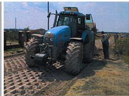
Rys. 5. Mieszanie ubitego spoiwa z mieszanką gruntu 1 ze stabilizatorem (G-S)
