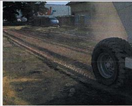
Rys. 3. Rozścielanie spoiwa na mieszance gruntu 1 ze stabilizatorem (G-S)
